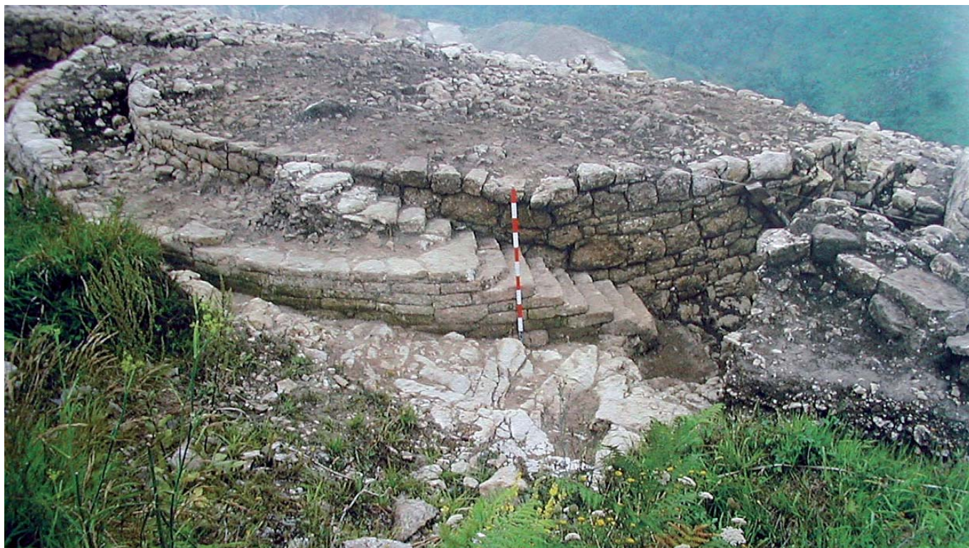
Escalera de acceso a la muralla del castro de Llagú (Oviedo) (Foto de Maya y Mestres).
